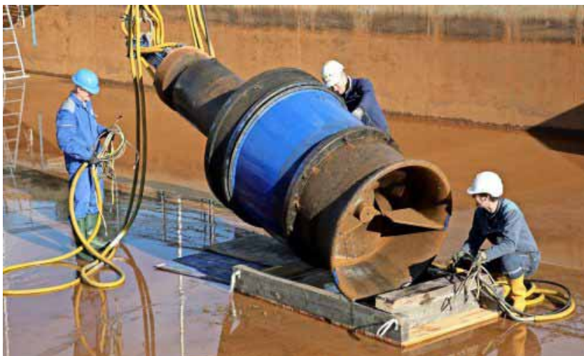
Die Pumpen im Kanupark in Markkleeberg werden zur Wartung in eine Werkstatt nach Halle gefahren. Dazu müssen sie von Fachleuten komplett ausgebaut werden. Fotos: A. Kempner
